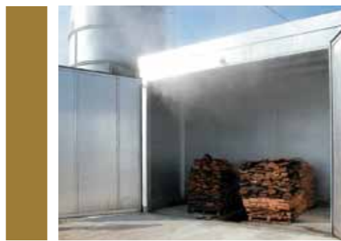
Impianti di Vaporizzazione
