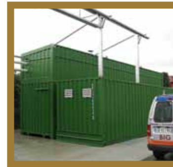
Centrale Termica con Silos abbinato
